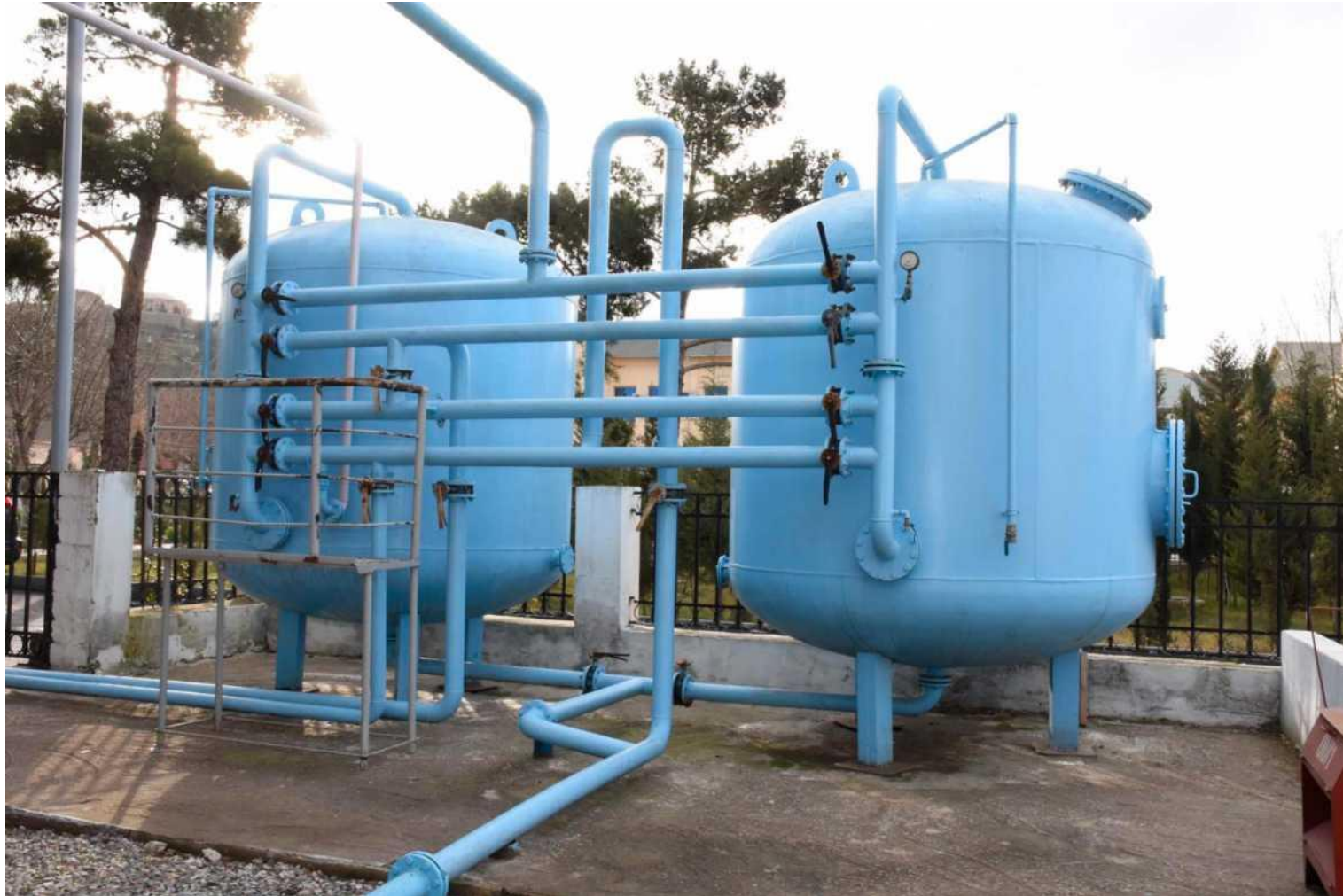
Tutumu 60 m 3 olan su sakitləşdirici çənlər (Stagnant tanks with a capacity of 60 m 3 ) (Ёмкости с вместимостью 60 м 3 для отстаивания воды)
